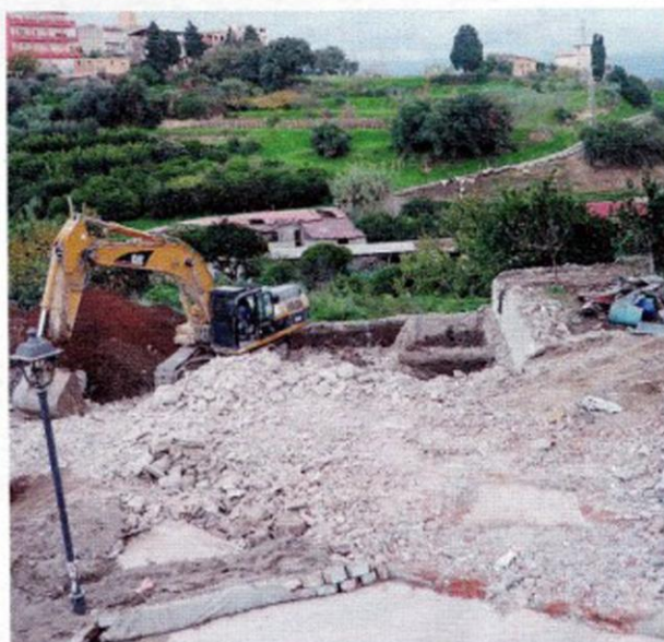
Ruspe al lavoro nell'area Murat per demolire le casupole fatiscenti
