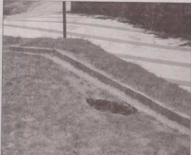
Il "fornello" a ridosso del centro abitato poi chiuso con una colata di cemento; sotto la galleria di Piale
