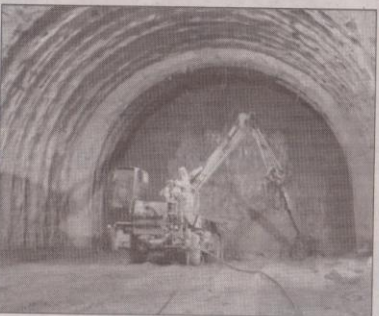
Il "fornello" a ridosso del centro abitato poi chiuso con una colata di cemento; sotto la galleria di Piale
