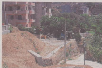
L'area adiacente ai lavori in corso sull'autostrada A3
